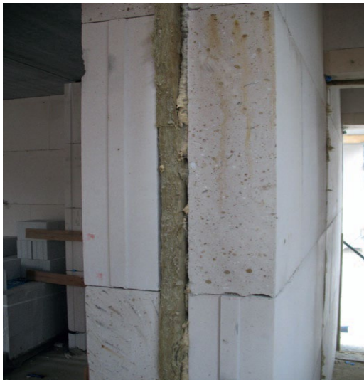
Figure 3.8. Détails d'exécutions de murs creux sans ancrage
