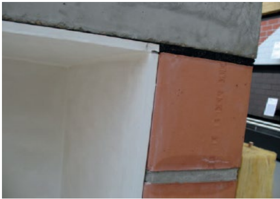
Figure 3.12. Finition en enduit à l'endroit de la jonction entre le mur et le plafond
