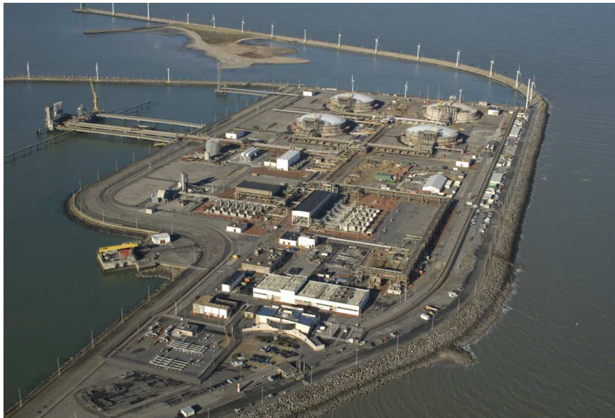
Photo 1 : Terminal de GNL de Zeebruges, 2009
